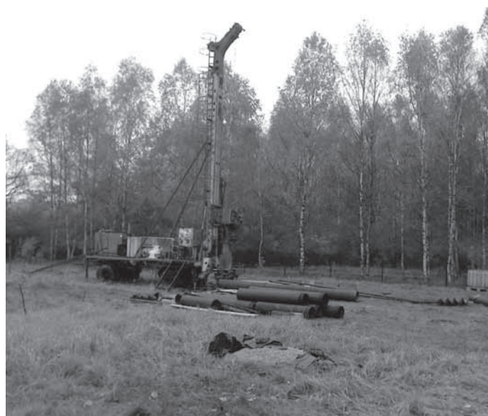
W Brušku powstanie nowe ujęcie wody.
