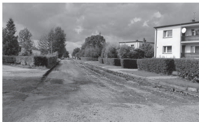
Ulica Bema w Koszęcinie już w budowie.
