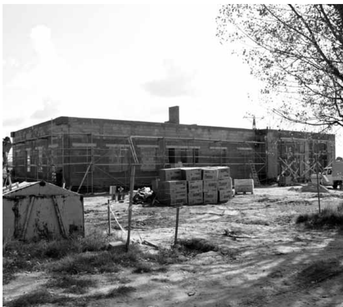
Powstaje budynek wielofunkcyjny w Sadowie.
